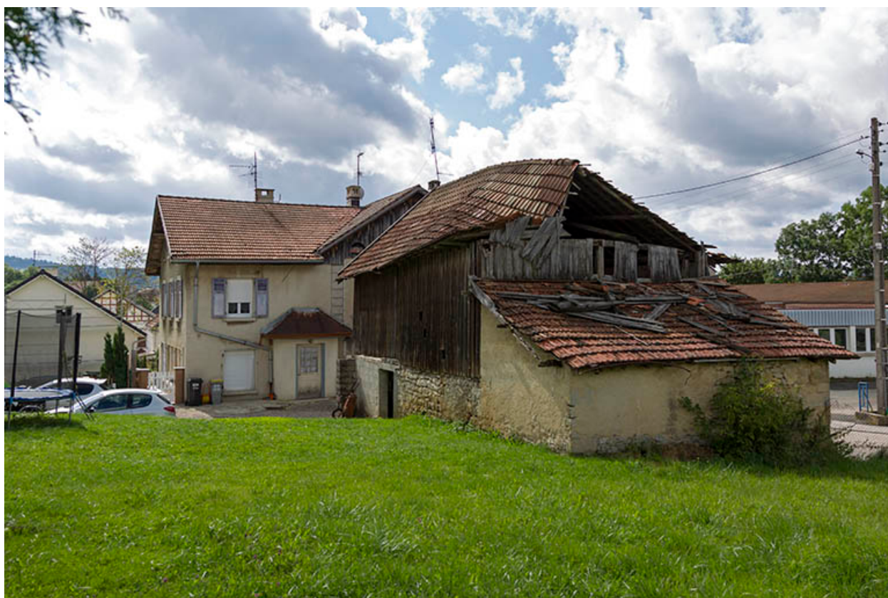
Remise et logement patronal (façade latérale gauche).
