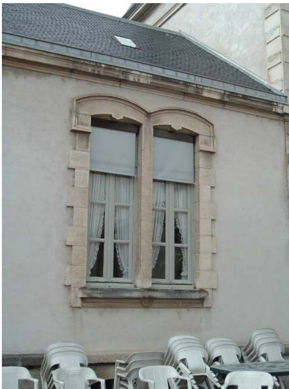
Vue de détail d'une baie gémée (aile gauche surbaissée).
