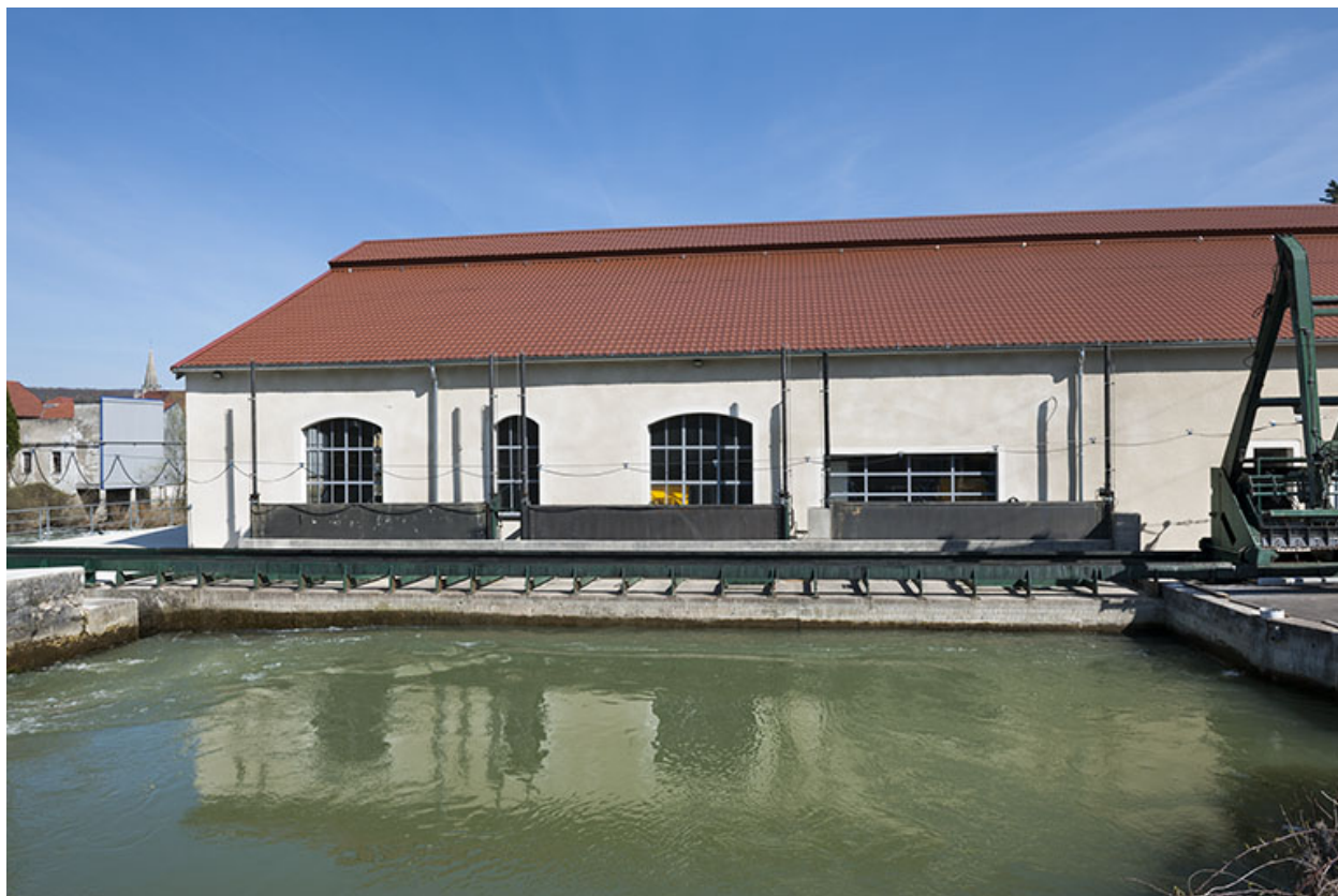
Bief d'amenée de la centrale hydroélectrique.
