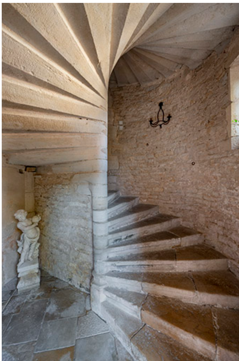
Escalier en vis, rez-de-chaussée.
