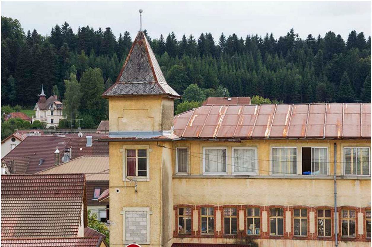
Usine, façade postérieure : tour orientale.
