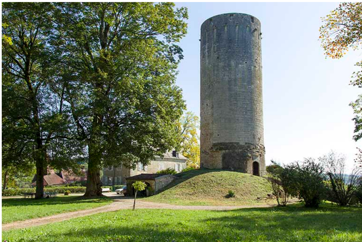
Vue générale du donjon depuis le parc.
