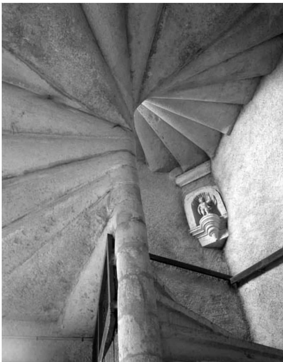
Partie gauche du couvent : détail de l'escalier en vis desservant le bâtiment en fond de cour.
