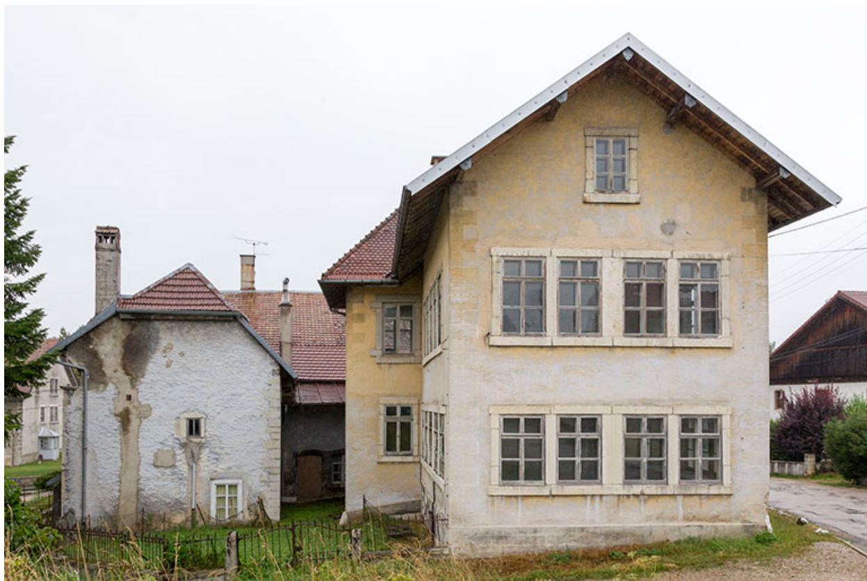
Usine : façade latérale gauche.
