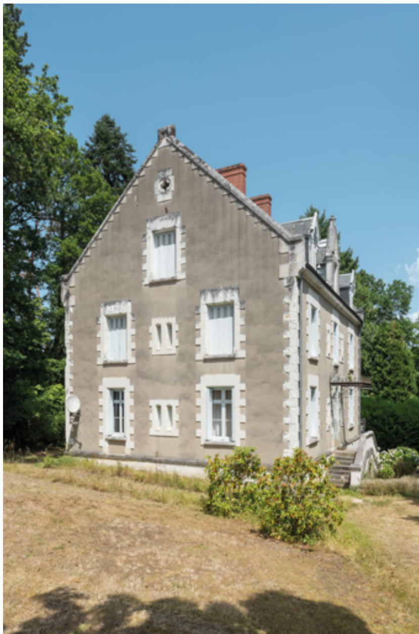
Mur pignon sud-ouest.
