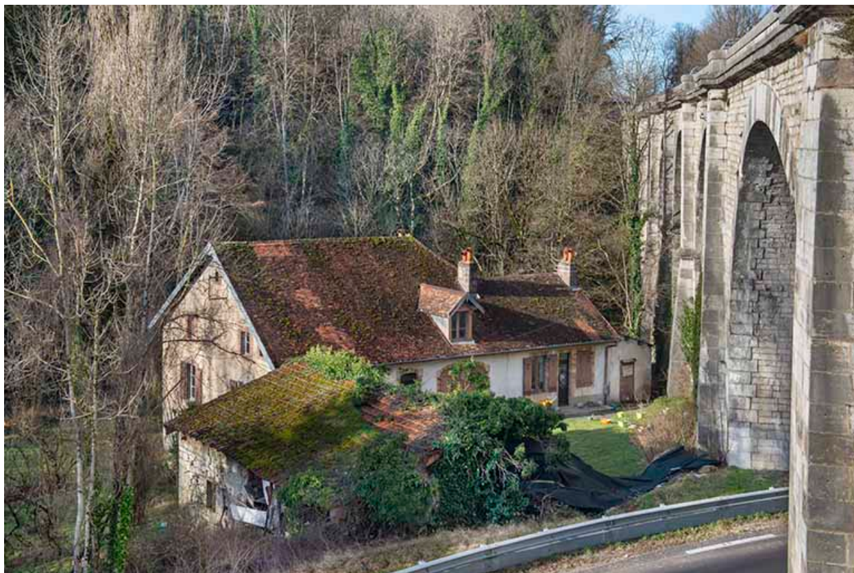
Virage et viaduc, vus de trois quarts.
