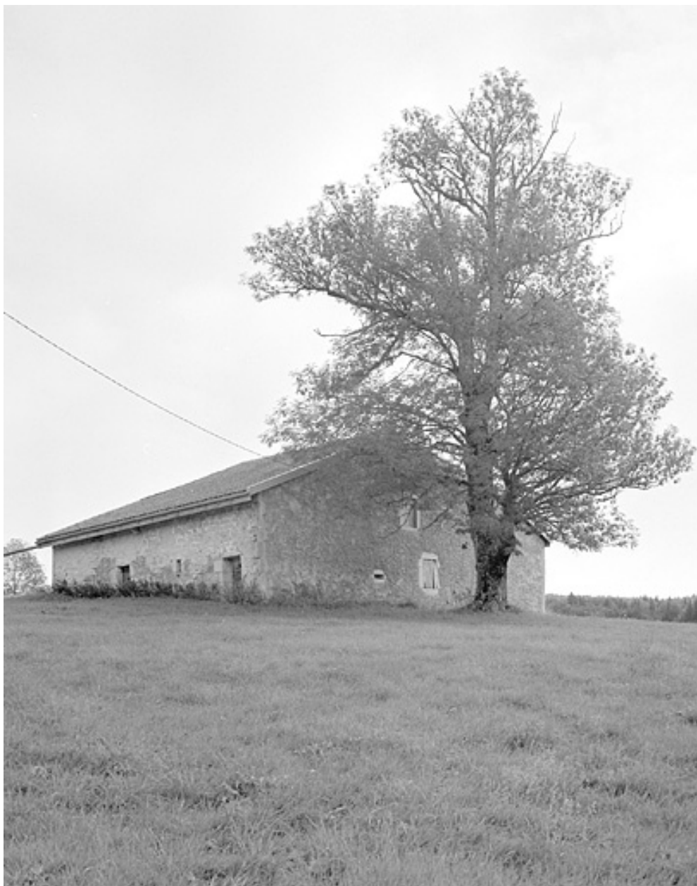
Face sud-ouest et façade postérieure.
