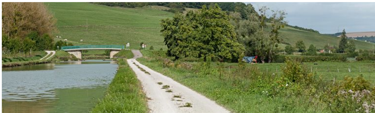
Vue du pont.
