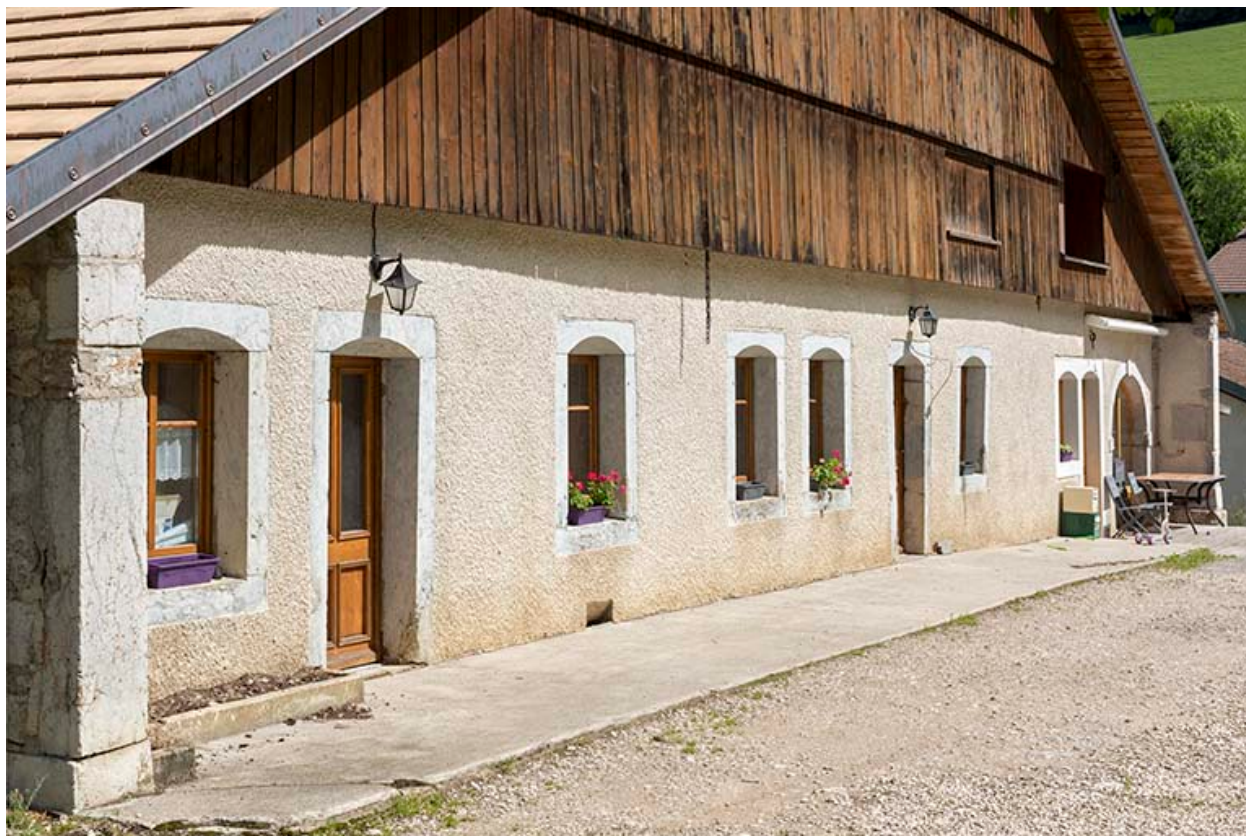
Façade antérieure, vue en enfilade.
