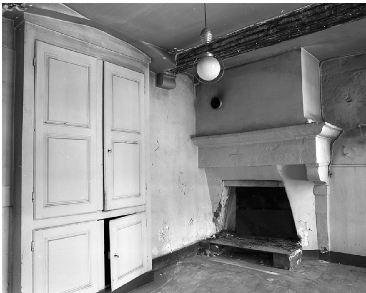
Communs : intérieur de la cuisine.
