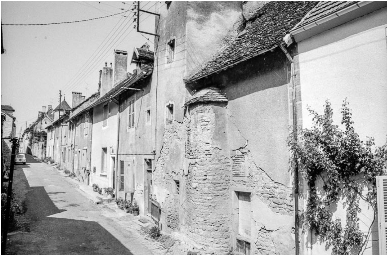
Maisons rue Haute-du-Bourg : façades sur rue.
