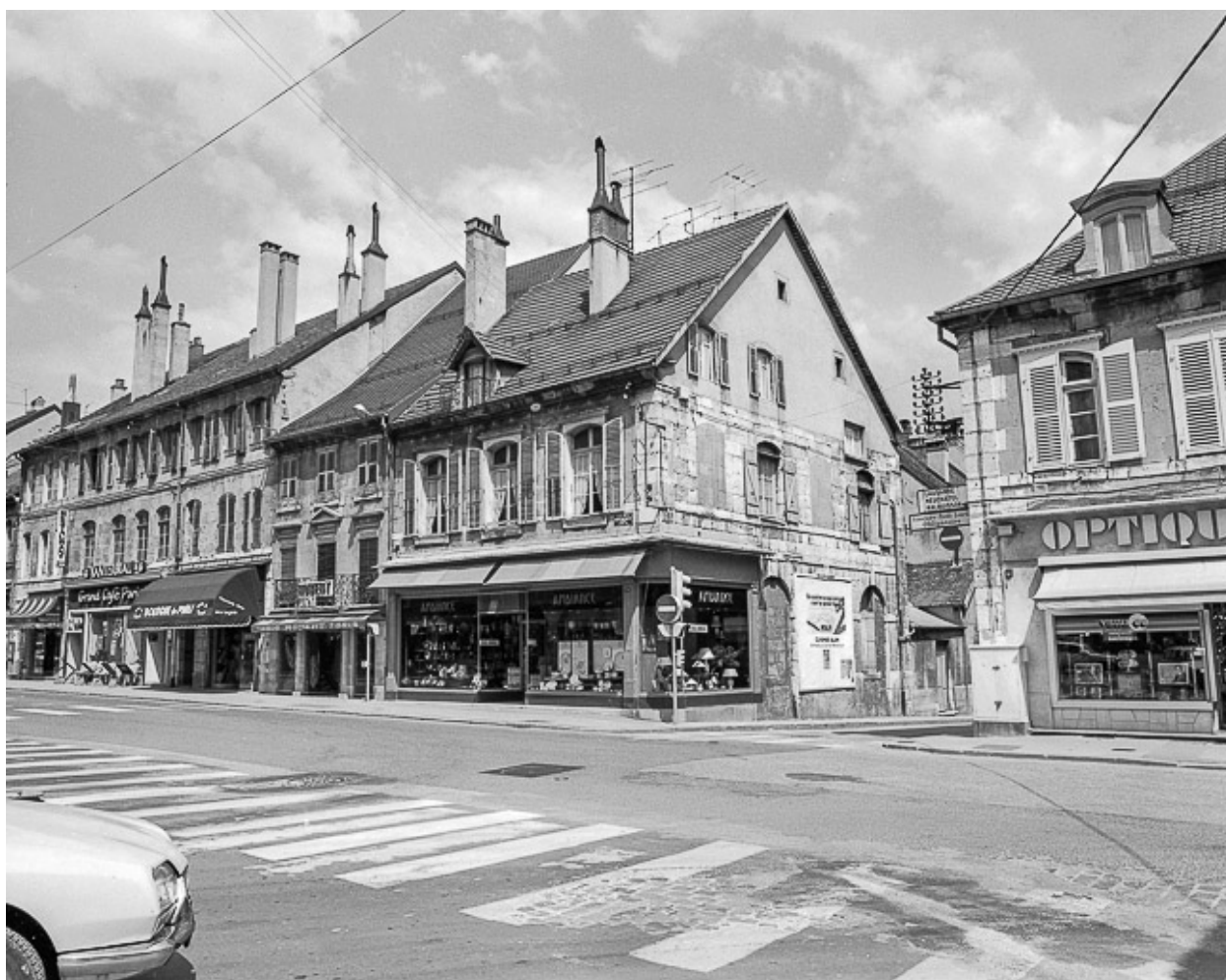
Maisons situées 16 à 22 rue de la République.
