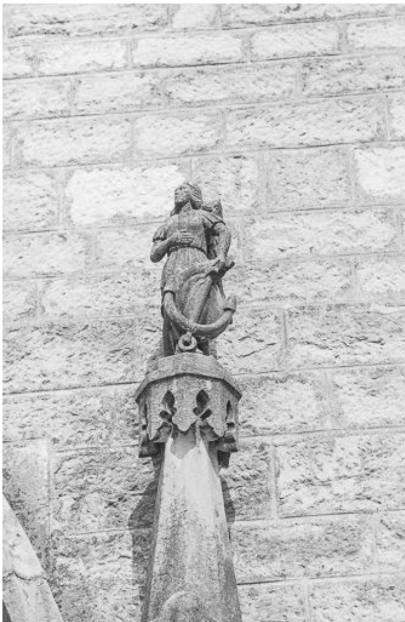
Extérieur : portail, façade antérieure, détail.
