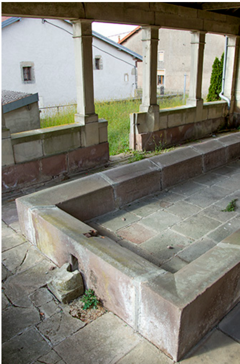
Bassin du lavoir rue Saint-Antoine.
