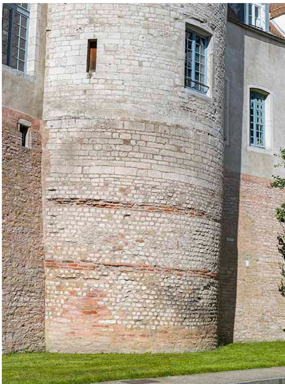
Détail de la maçonnerie, tour de l'Evêché.
