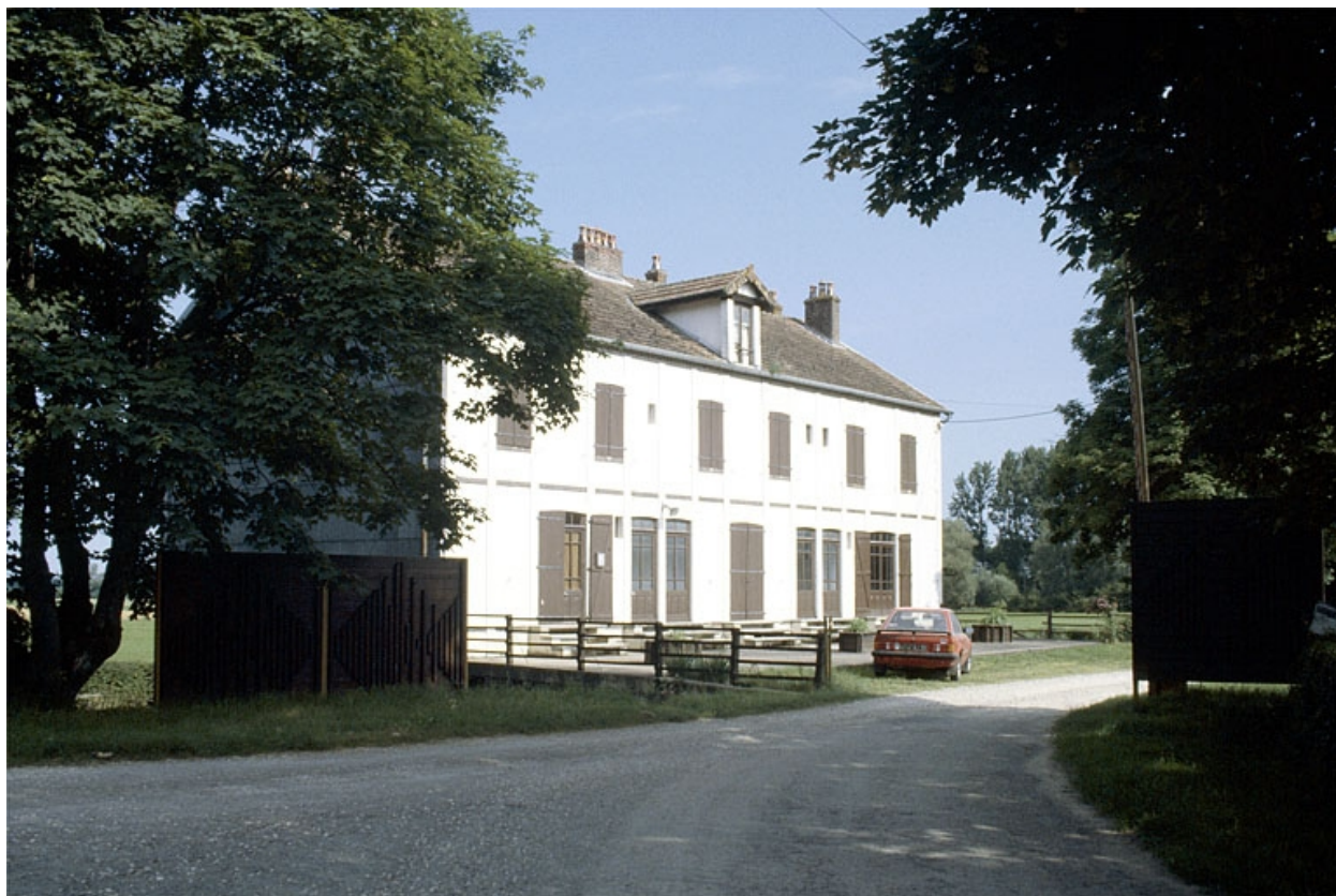
Logement d'ouvriers (O), depuis l'entrée de l'usine.
