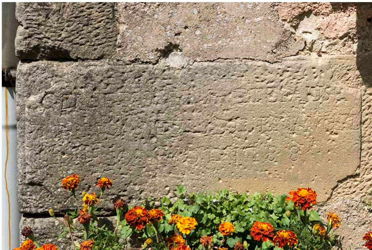
Détail : pierre de fondation (1788) (ancien moulin)
