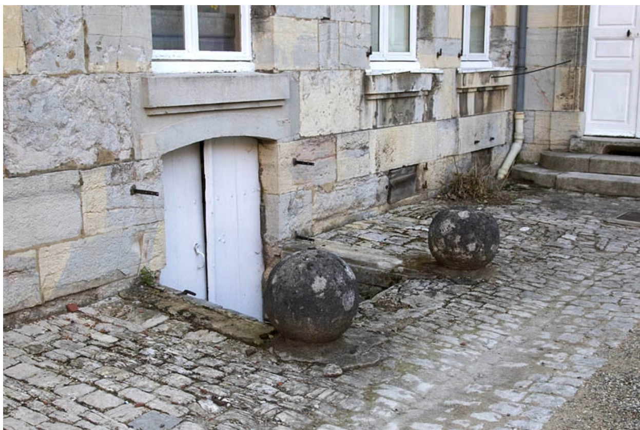
Cour : détail de l'entrée de cave.
