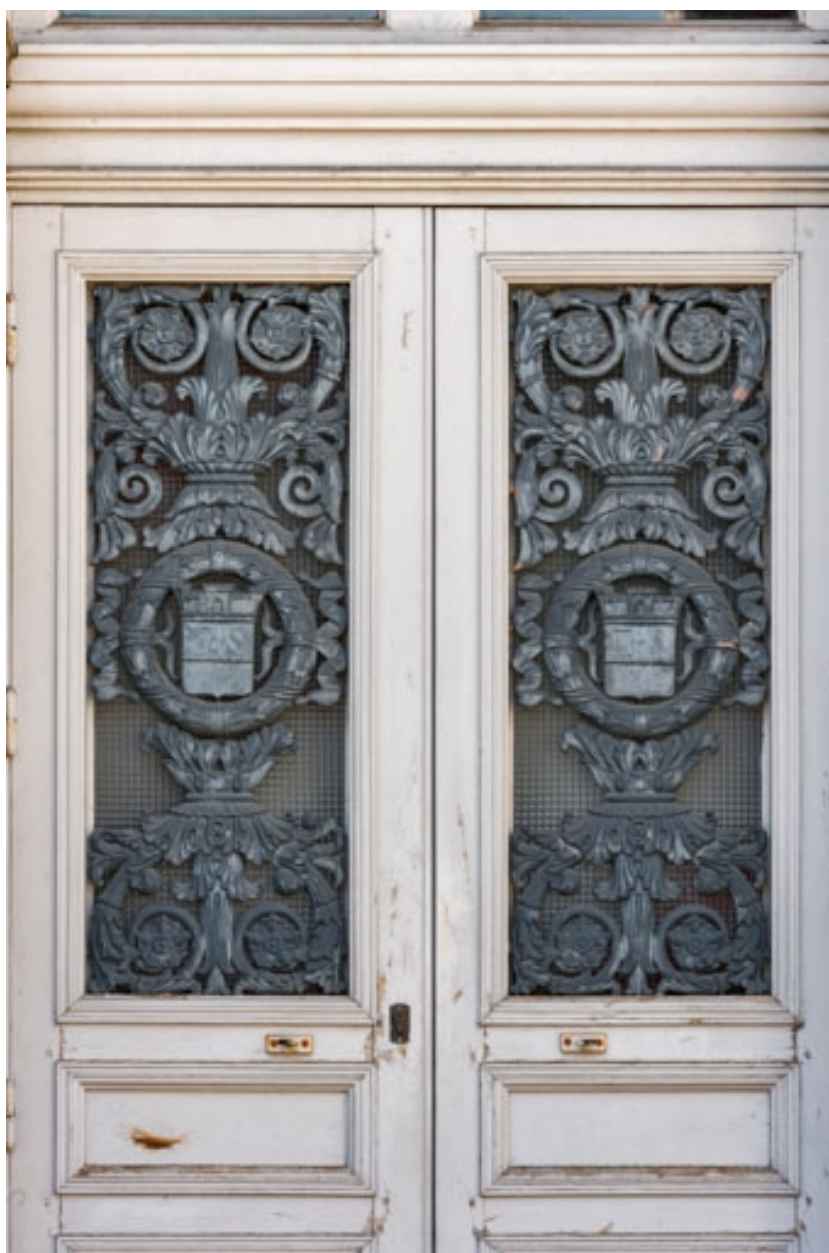
Façade antérieure : décor métallique d'une porte.
