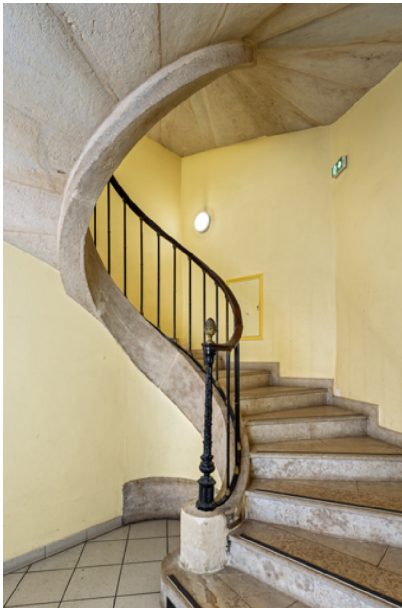
Rez-de-chaussée : escalier en vis.
