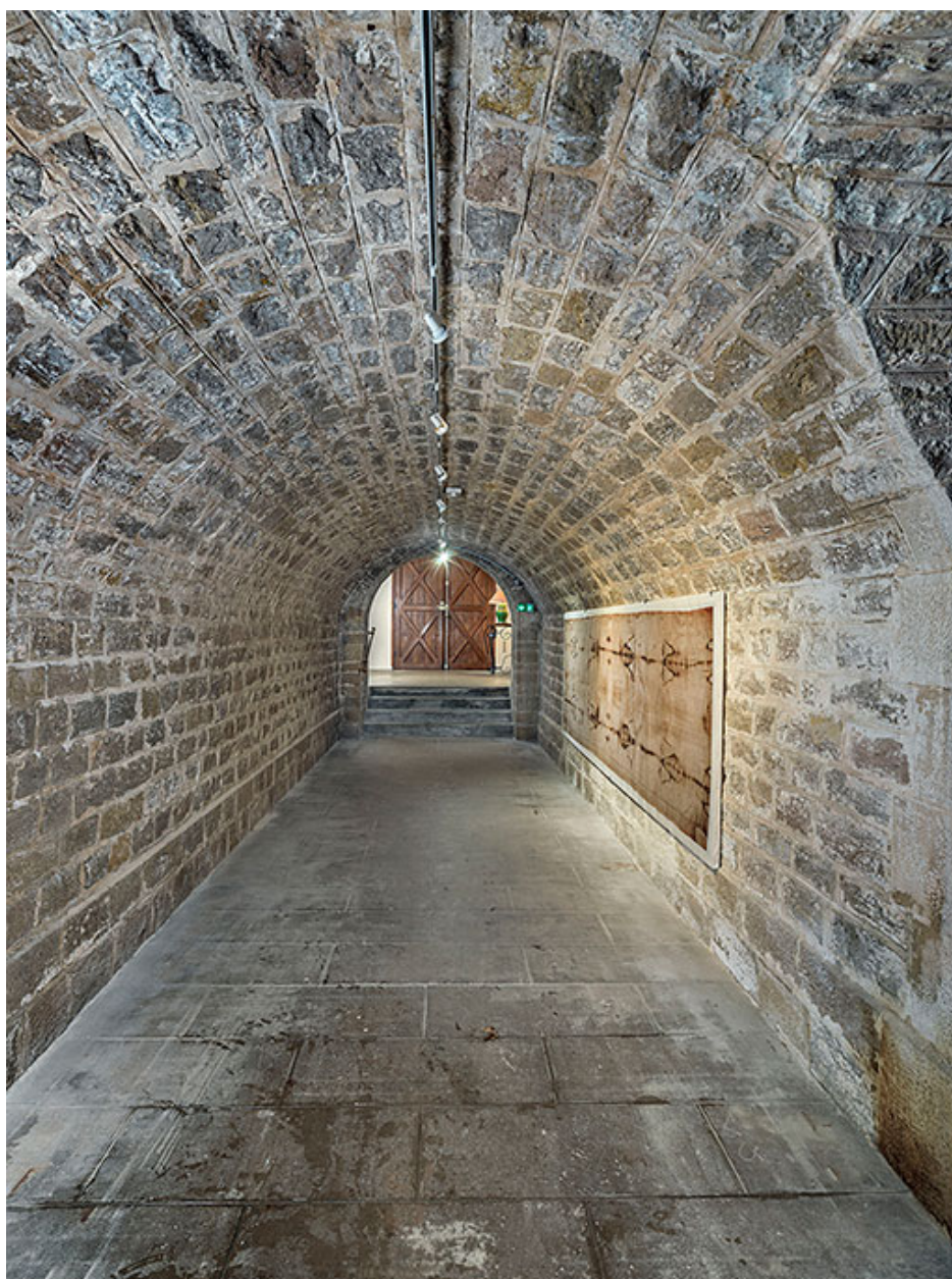
Galerie menant à la chambre de stockage.
