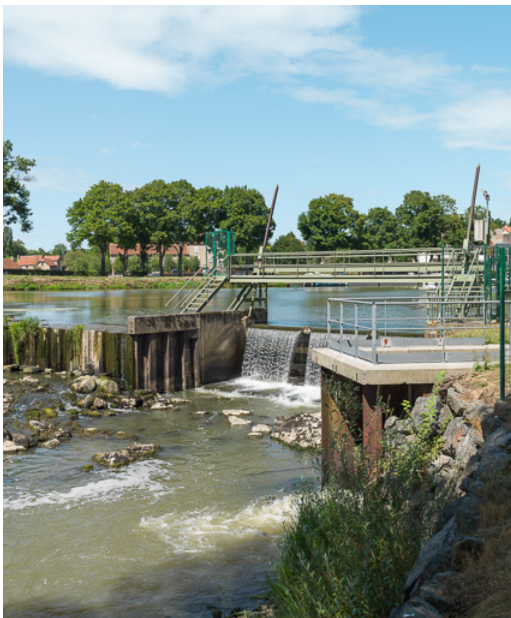
Vue du barrage.
