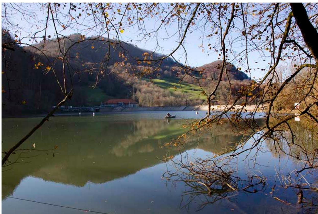
Digue et retenue, depuis l'amont.
