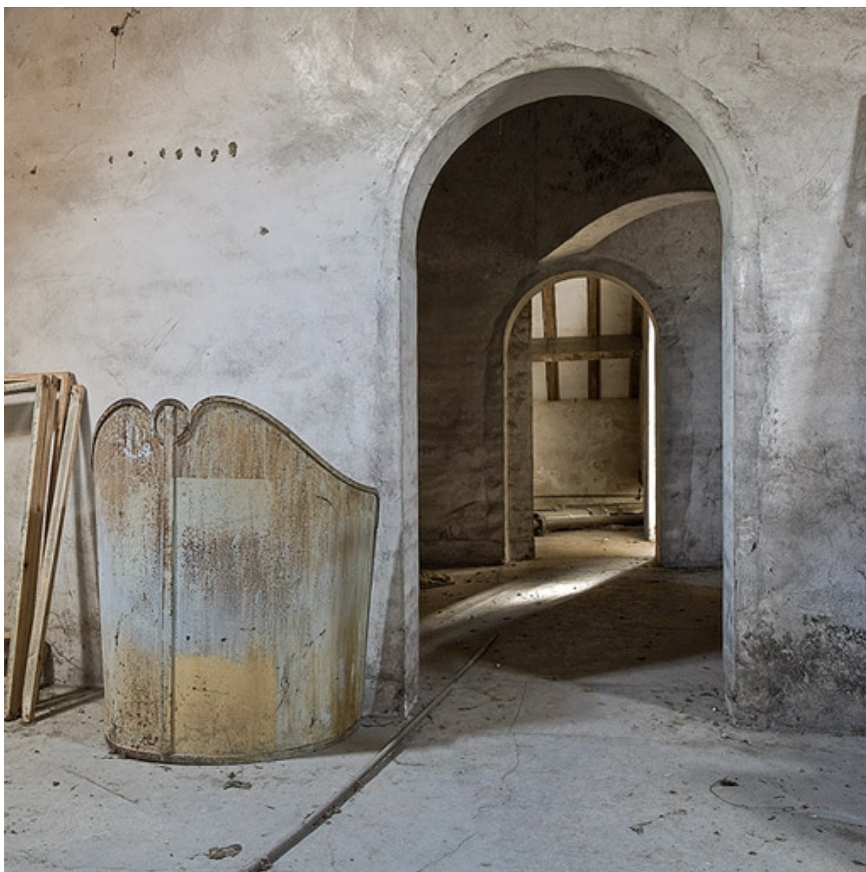
Comble : partie droite du corps central.
