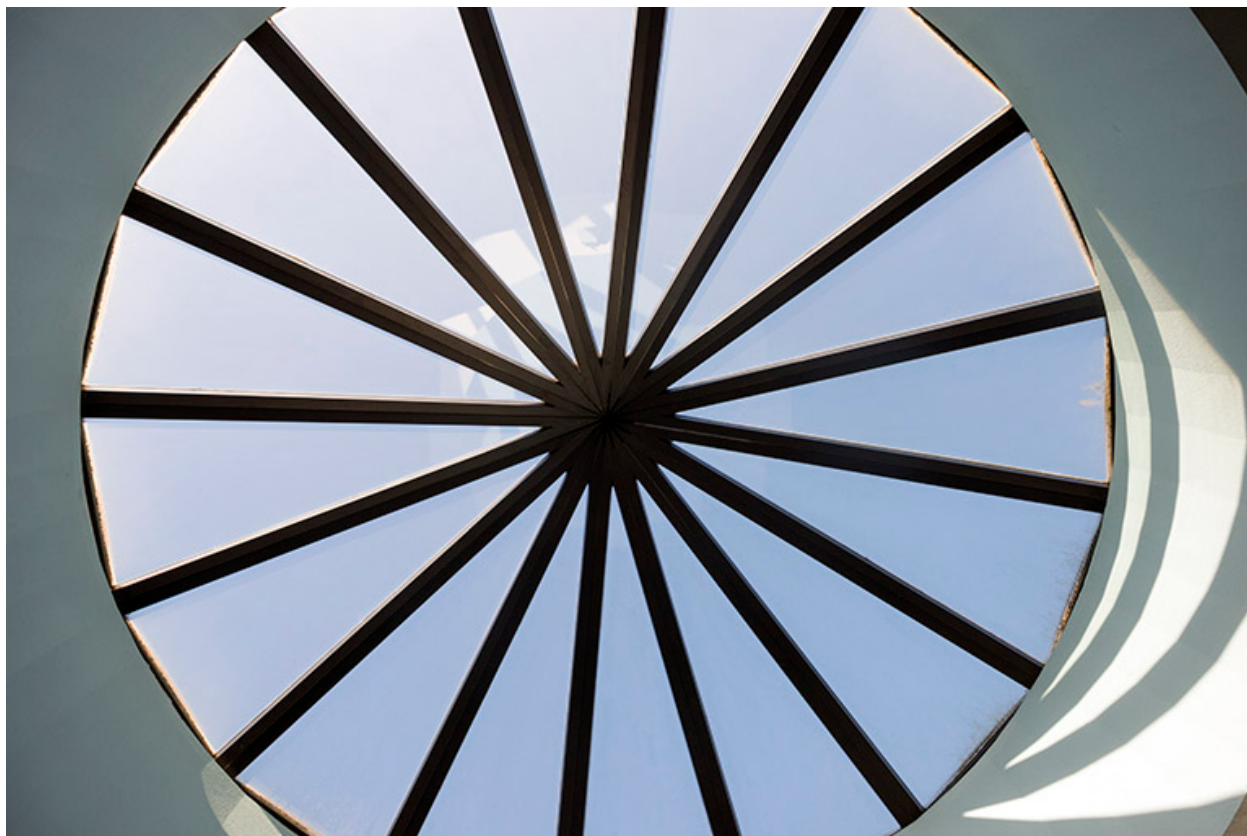
Détail intérieur de l'oculus zénithal du hall.
