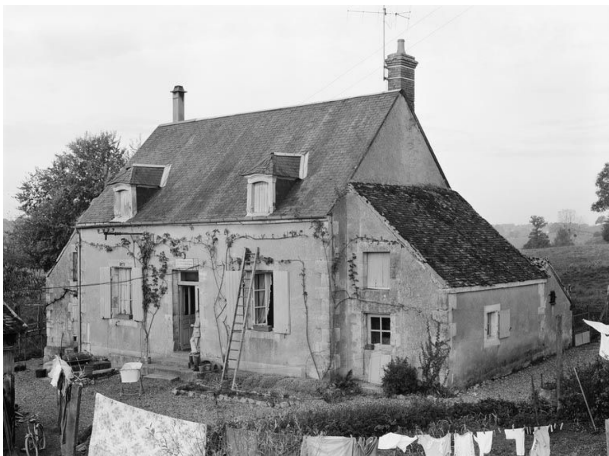
Vue d'ensemble de la maison éclusière.
