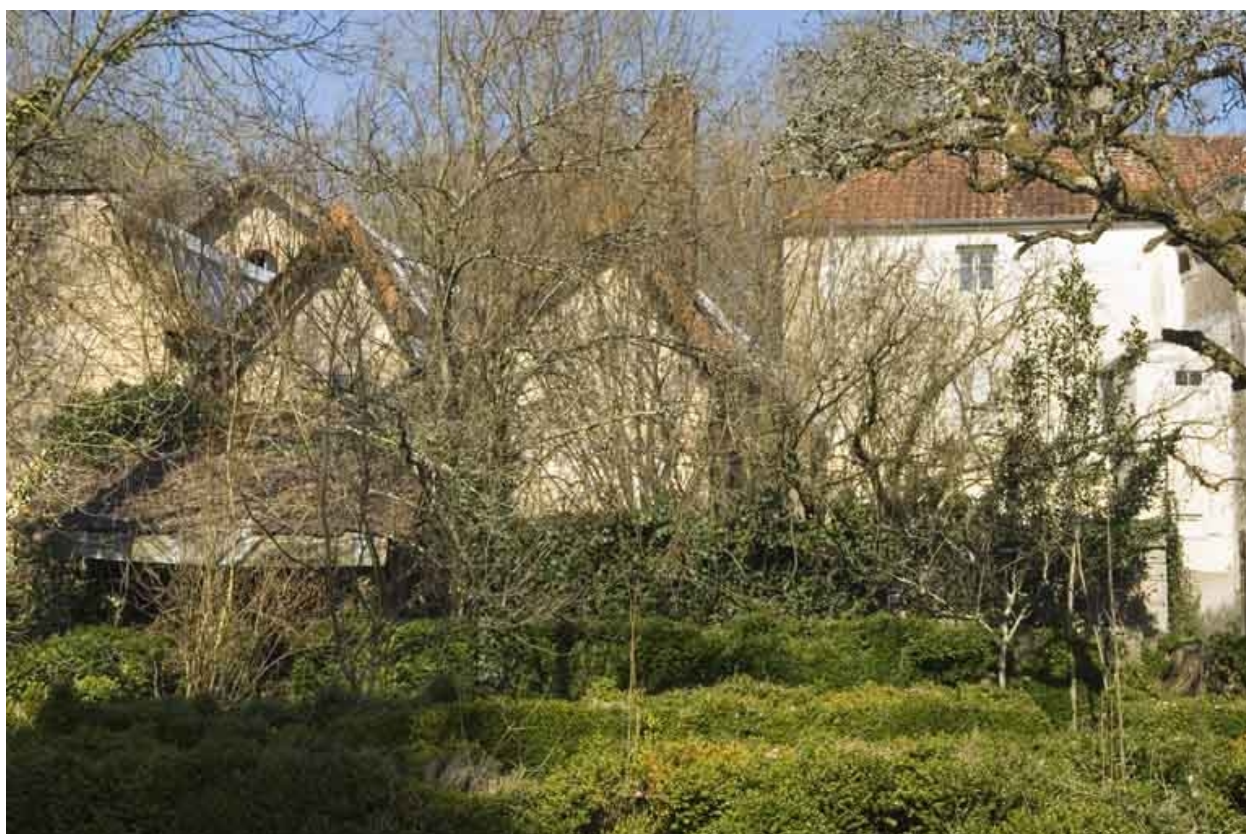
Atelier de fabrication et logement depuis l'ouest.
