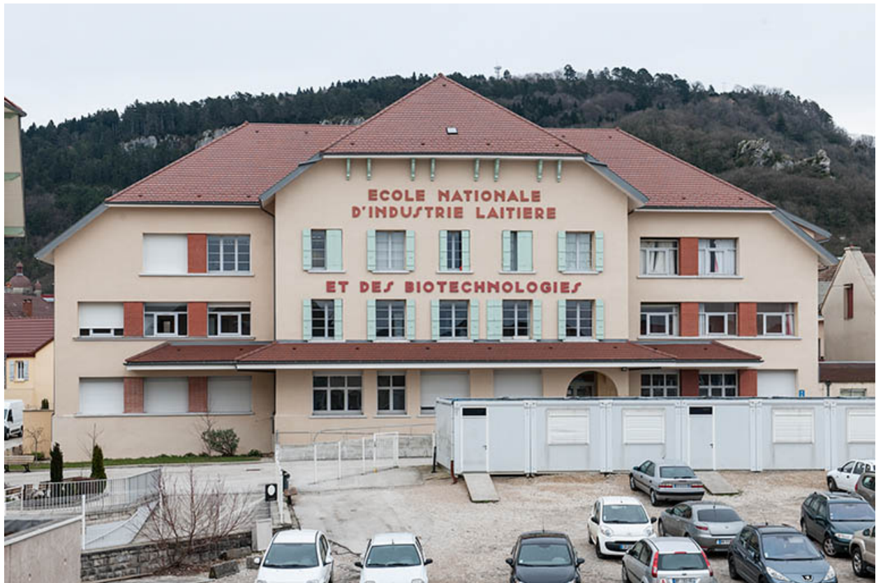
Façade antérieure ouest de l'école.
