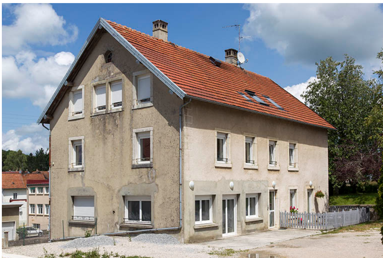
Façades postérieure et latérale droite.
