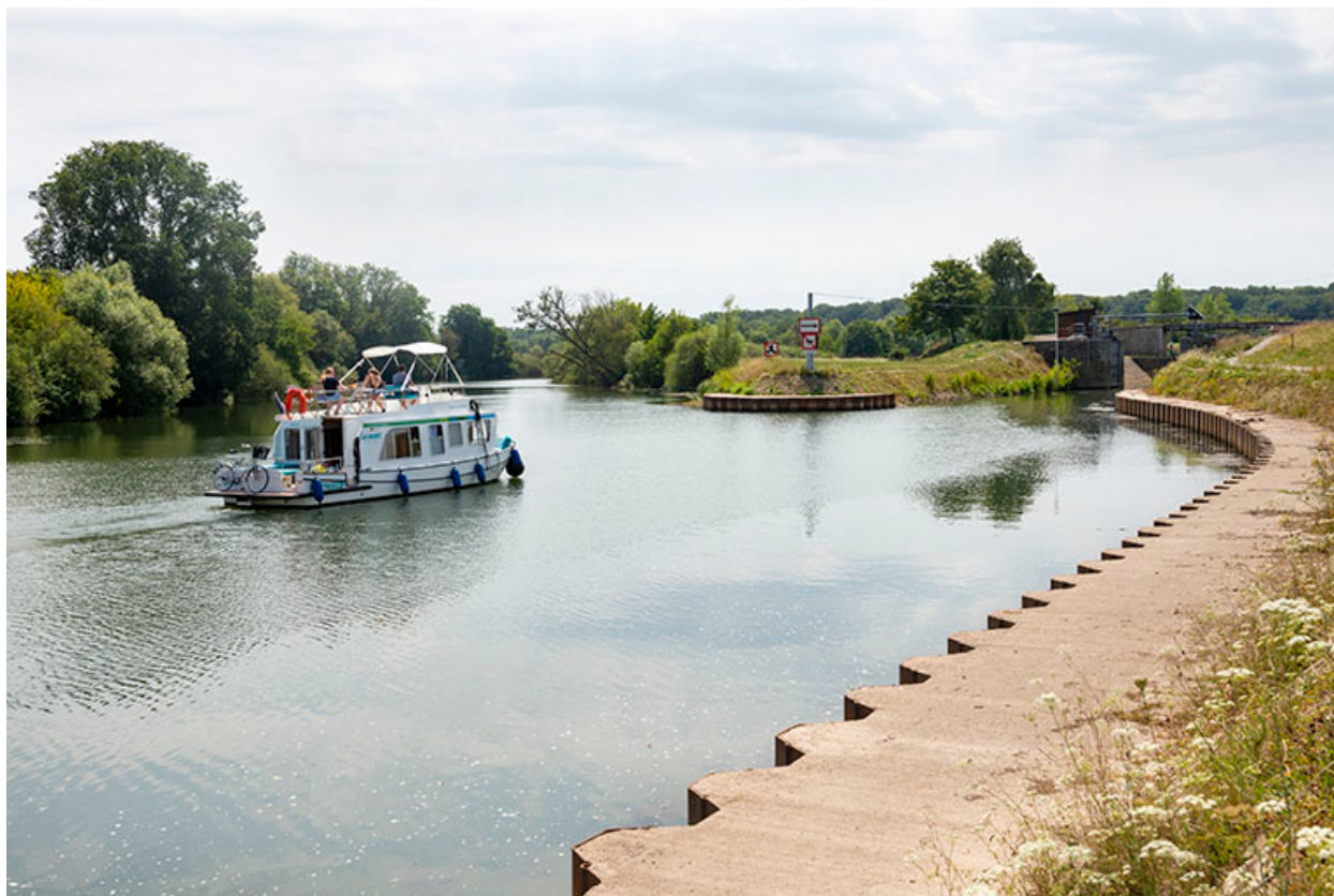
Entrée du canal de navigation de Cubry.
