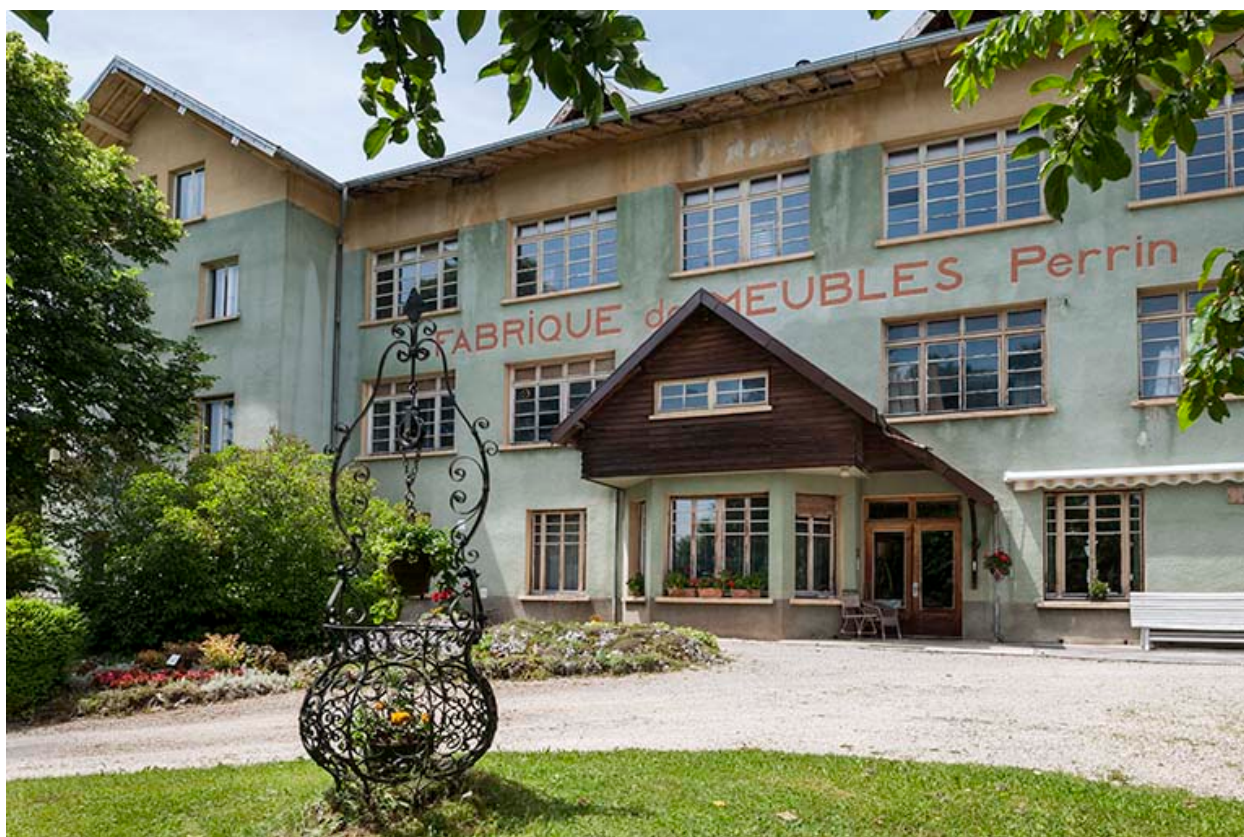
Atelier de menuiserie. Façade est.
