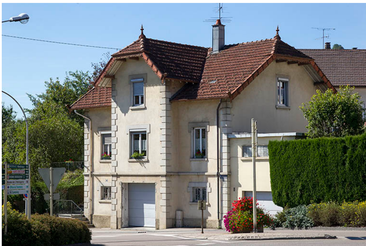
Façades antérieure et latérale droite.
