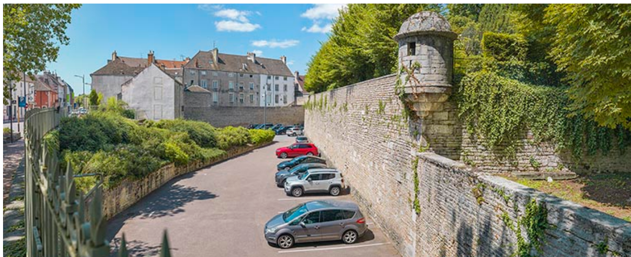
Vue d'une face du bastion.
