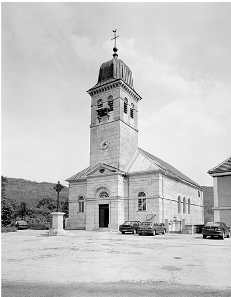
Façade antérieure et face droite.
