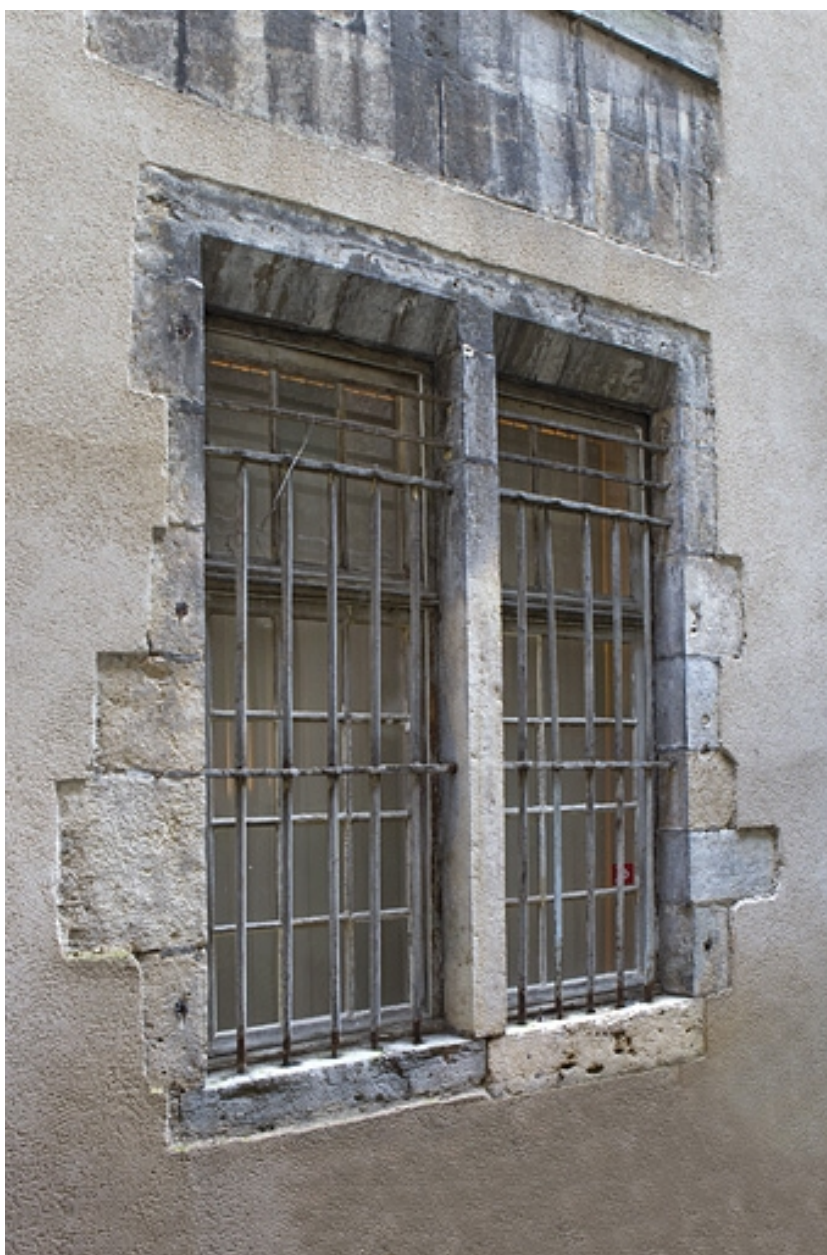
Logis principal : détail d'une baie.
