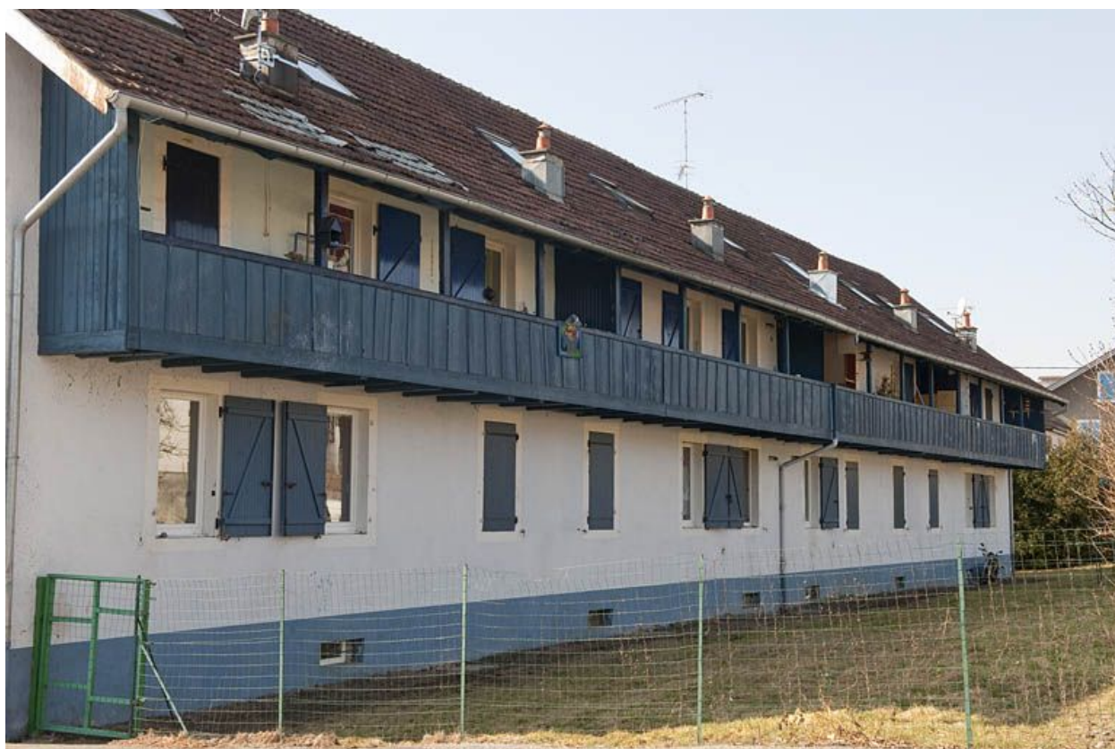
Immeuble de 12 logements. Façade postérieure.
