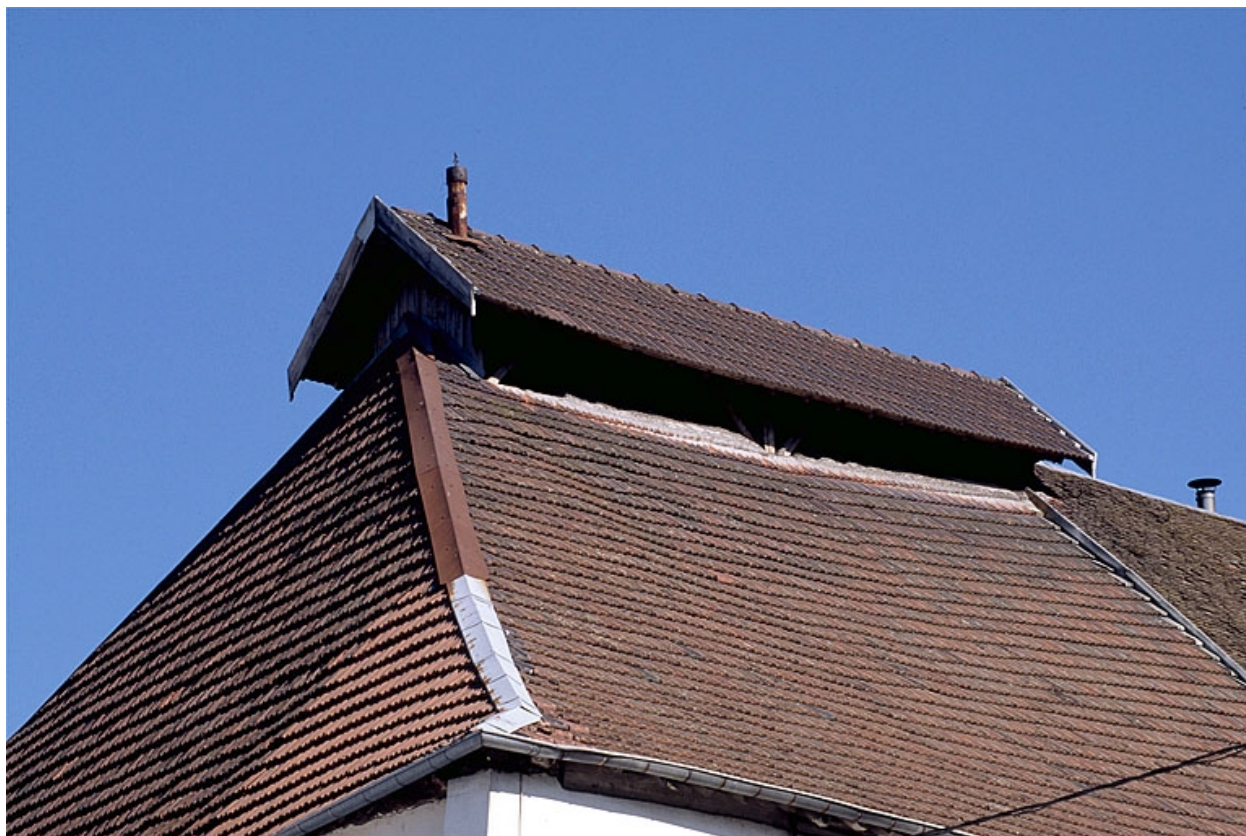
Atelier de fabrication : détail de la toiture.
