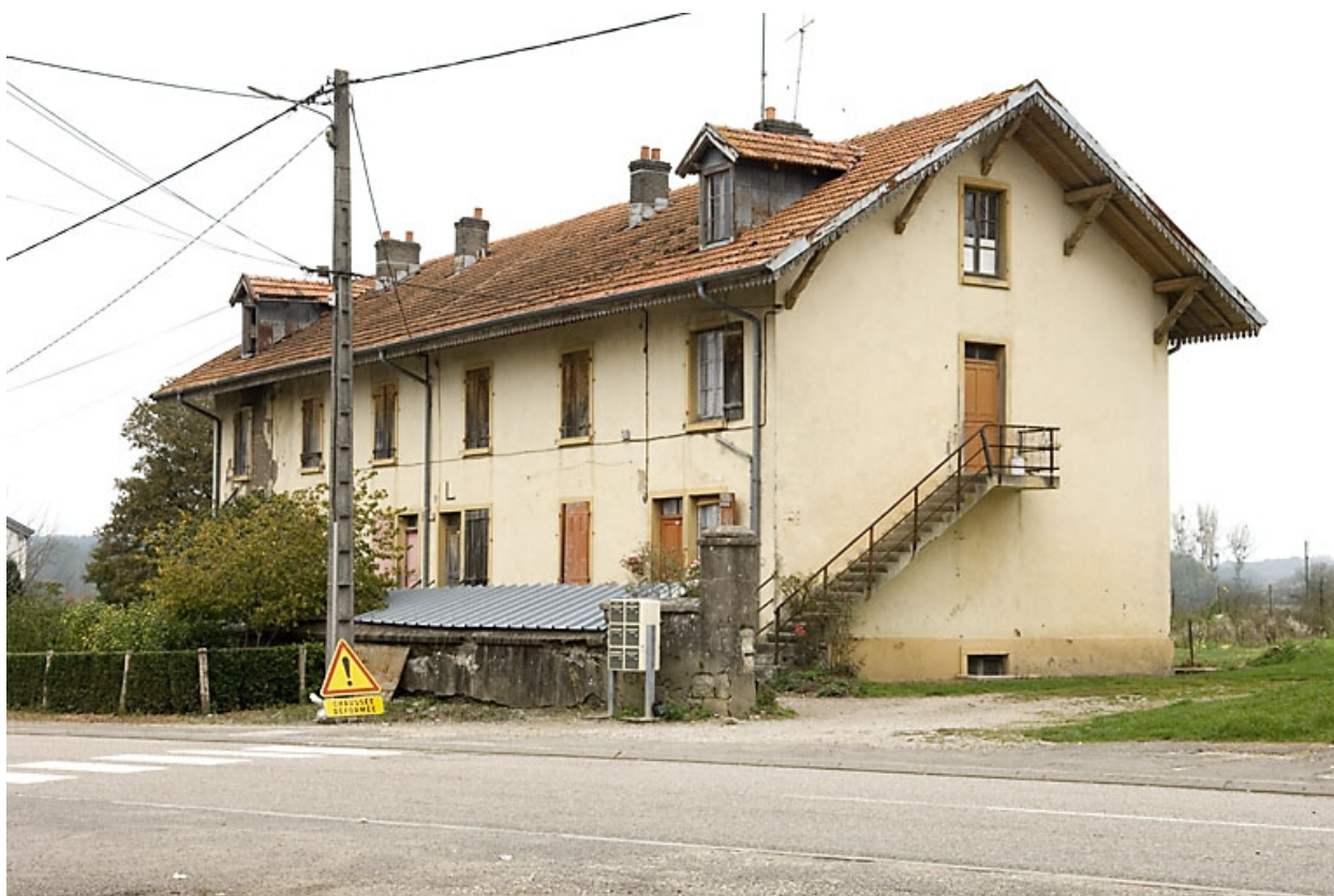
Logements d'ouvriers, bâtiment L, 4 rue du Coney.
