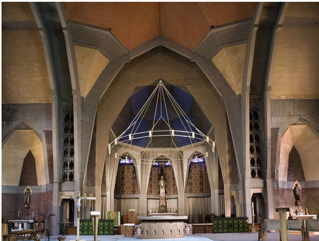
Vue générale du chœur.
