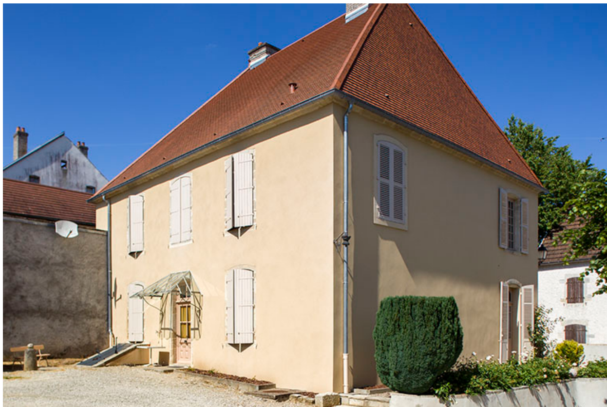
Façade postérieure de trois quart gauche.
