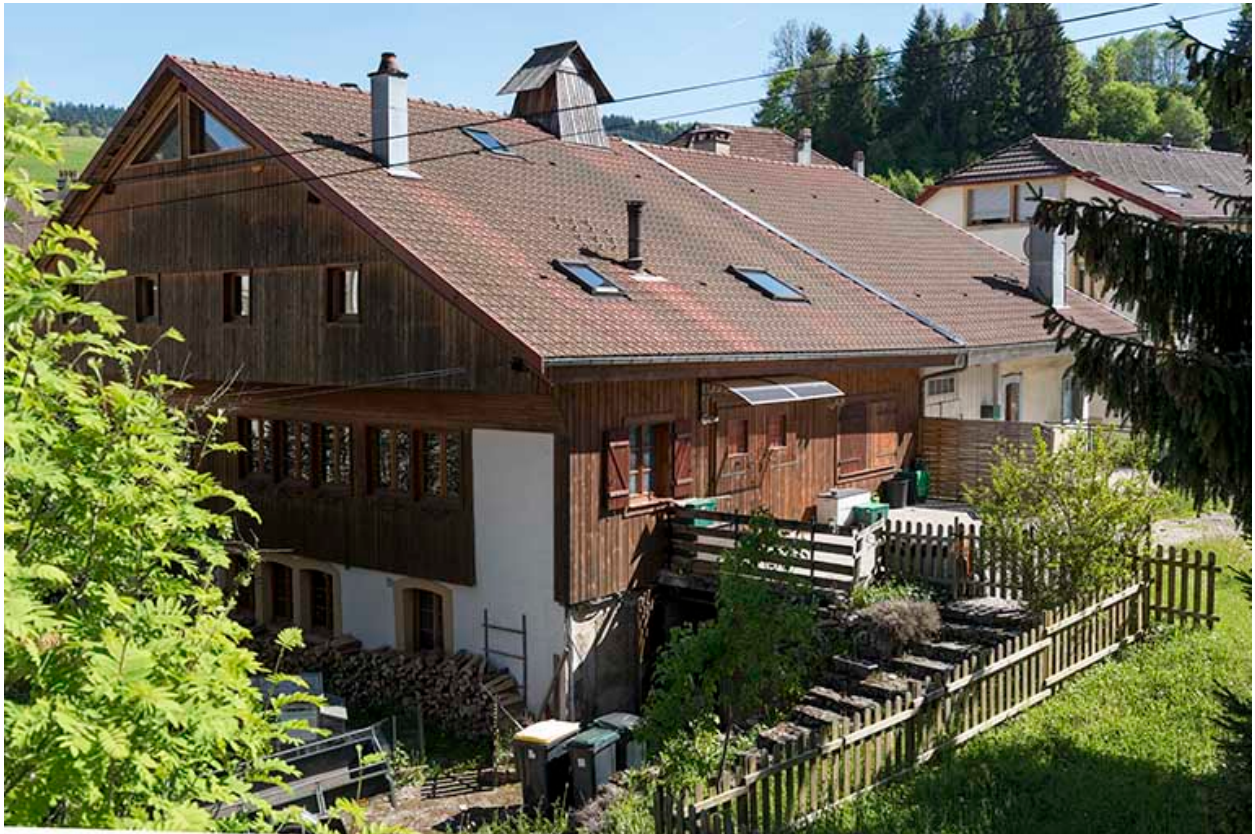
Façades postérieure et latérale droite.
