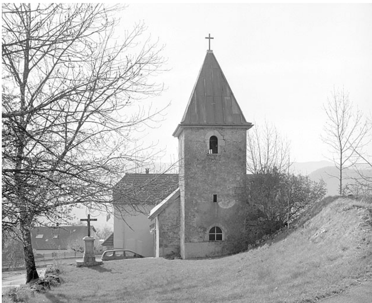
Vue générale depuis l'ouest.
