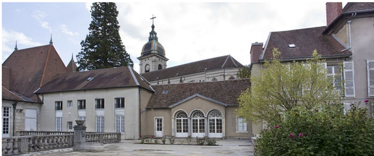
Orangerie : vue d'ensemble éloignée, de face.
