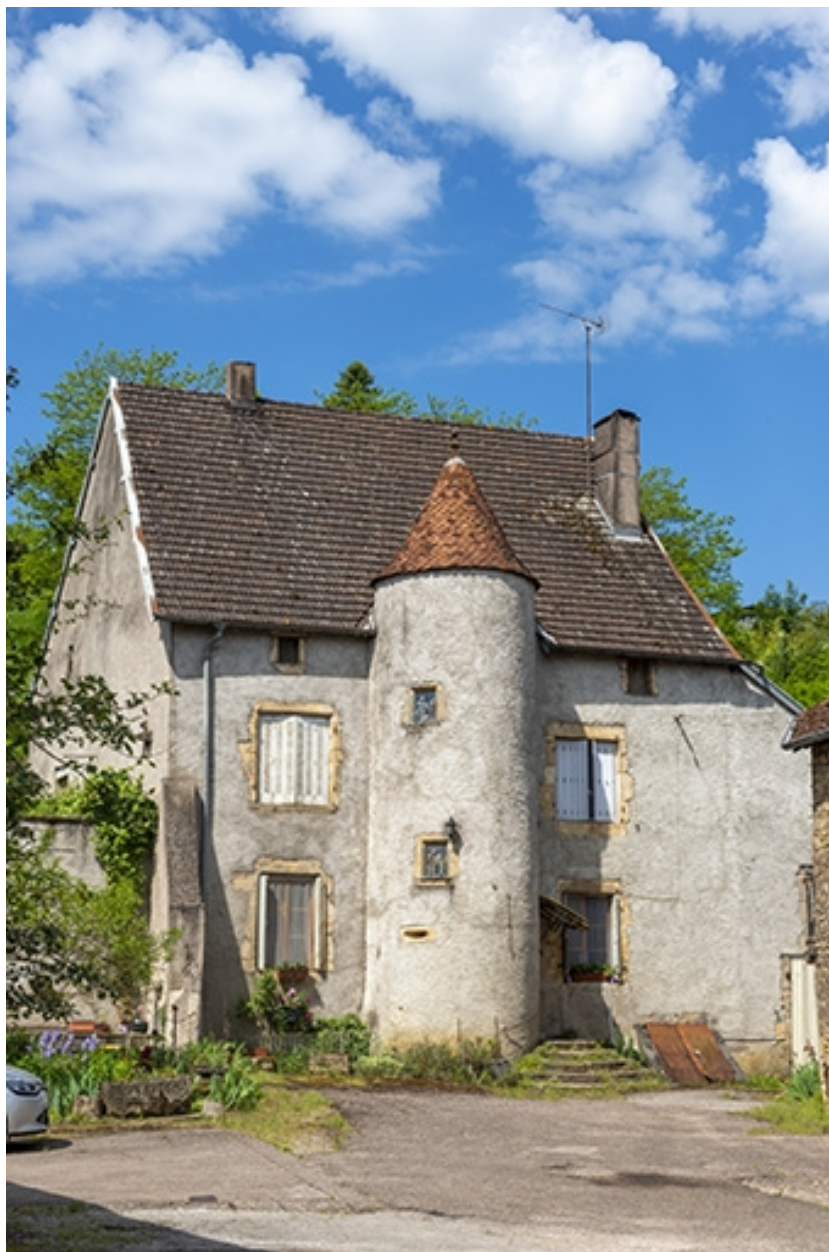
La façade antérieure depuis la rue.
