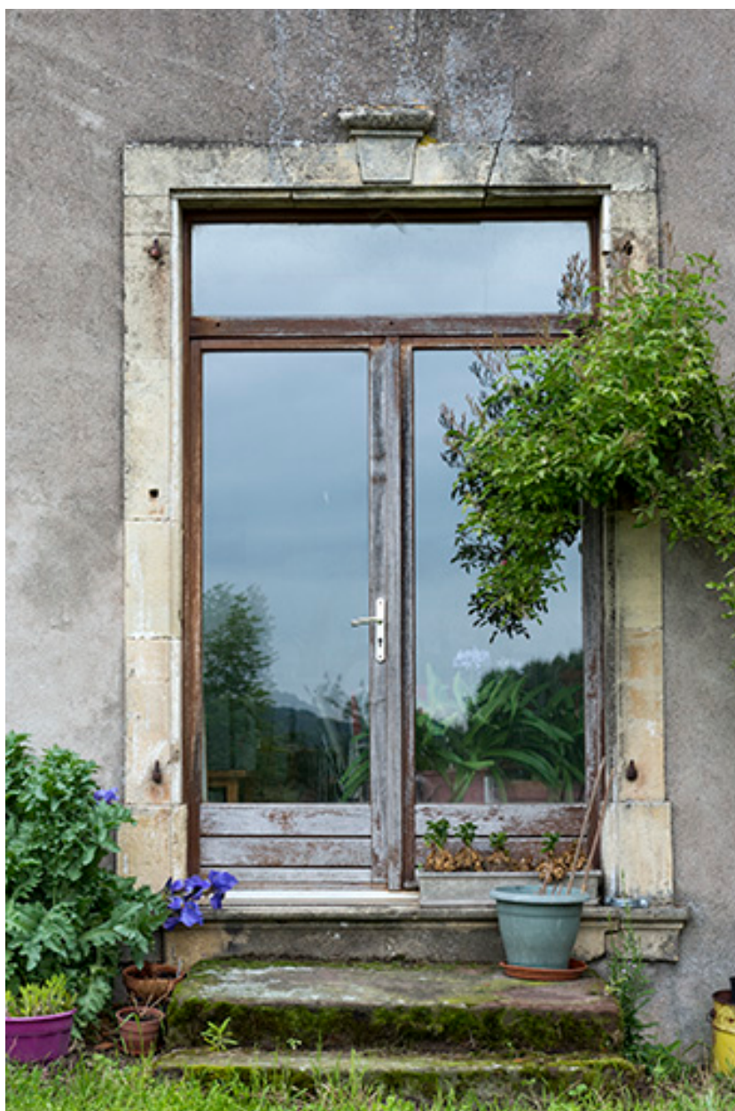
Détail d'une porte, façade postérieure.
