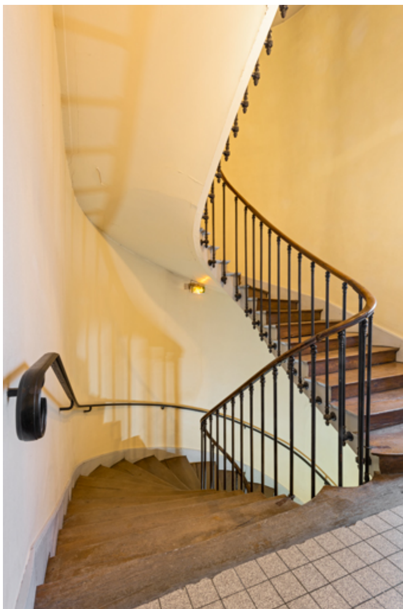
Escalier, au palier de l'étage carré.
